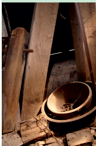
Věžní hodiny, stav před restaurováním, před lety snesené cimbalý; věž kaple Sv. Rodiny,
